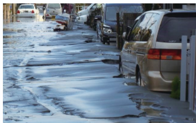
液状化で砂がふき出した例
