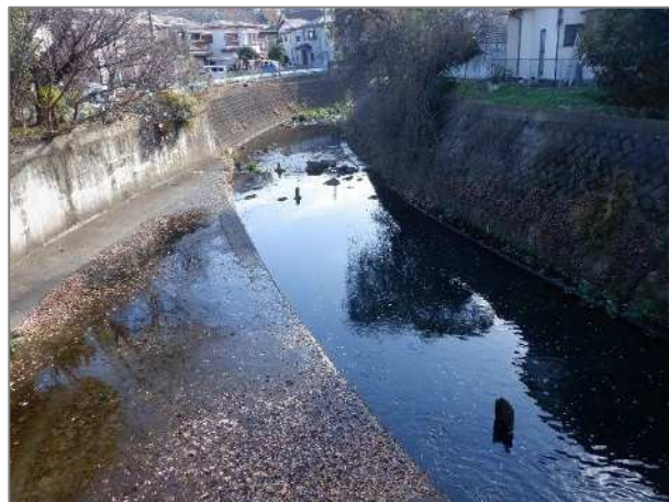
姥川への放流箇所
