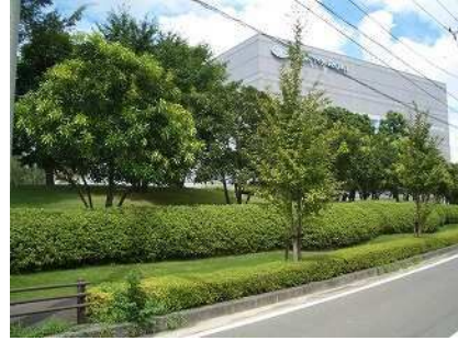
外周部を緑化した工場
