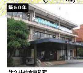
築60年 津久井総合事務所 建築年度：S39-H18 延床面積：2,434㎡
